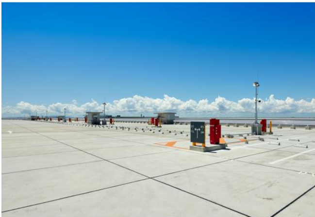
【A 棟屋上駐車場】
