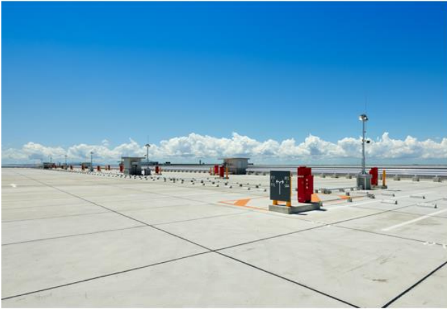
【A 棟屋上駐車場】
