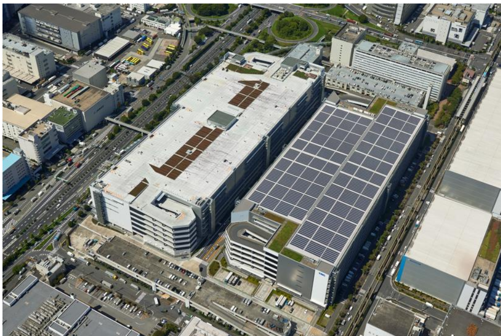
【物流ビル A 棟（左側）と物流ビル B 棟（右側）を核とした TRC 航空写真】
