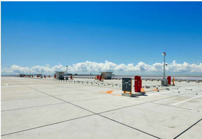
【A 棟屋上駐車場】
